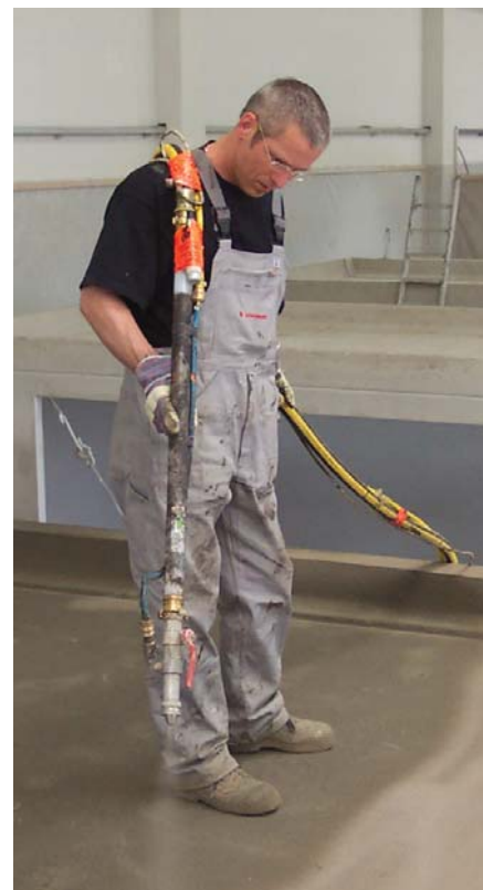
Гидроизоляция крыши гаража с помощью AQUAFIN®-2K
