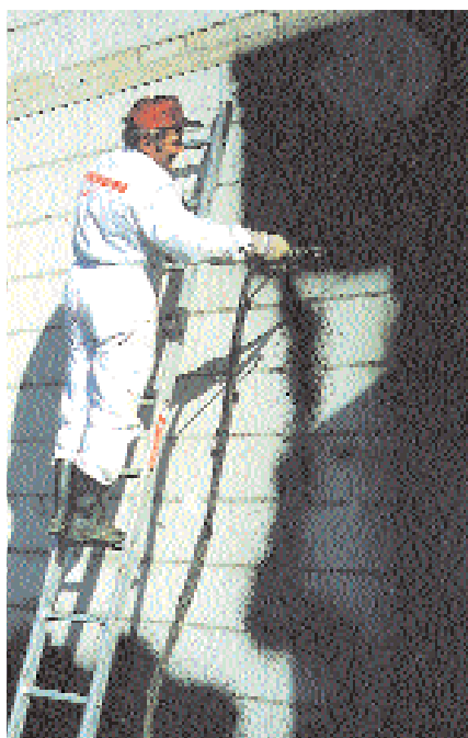
Гидроизоляция внешней стены подвала материалом COMBIFLEX®-C2
